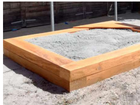
7.1 Sandkasse: 5 x 5 x 0,3m udfærdiget i robiniestolper eller ege træssveller
